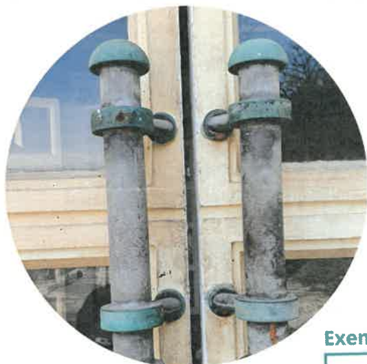
Piscine de Nérès-les-Bains Porte en béton armé - détail "Bâtons de maréchal"
